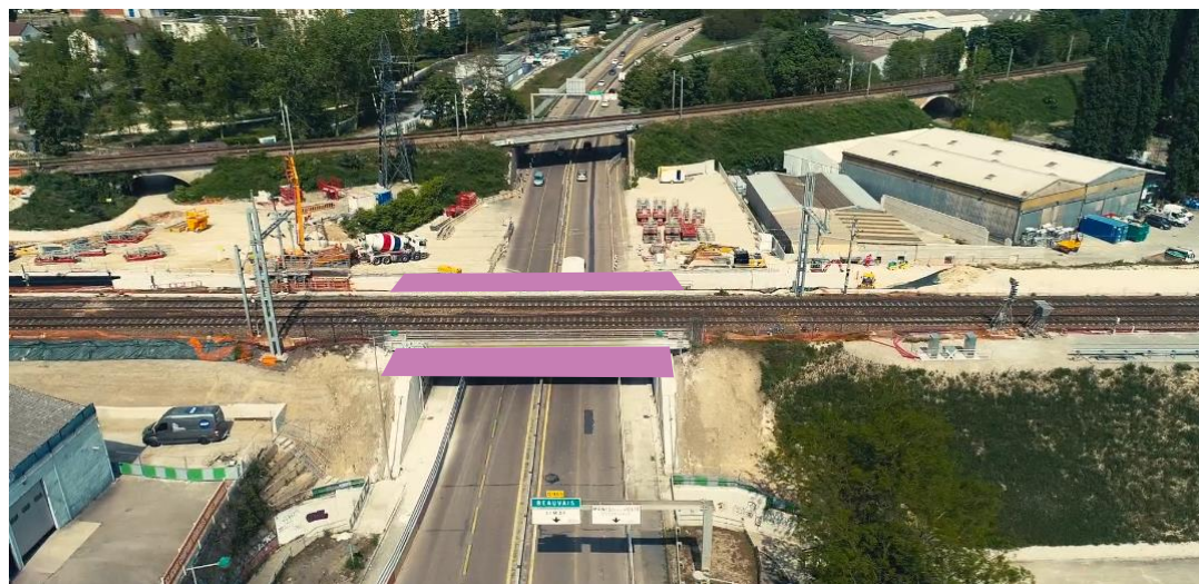
Élargissement pont-rail de Limay
